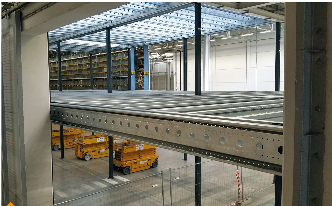
Plateforme de stockage.
