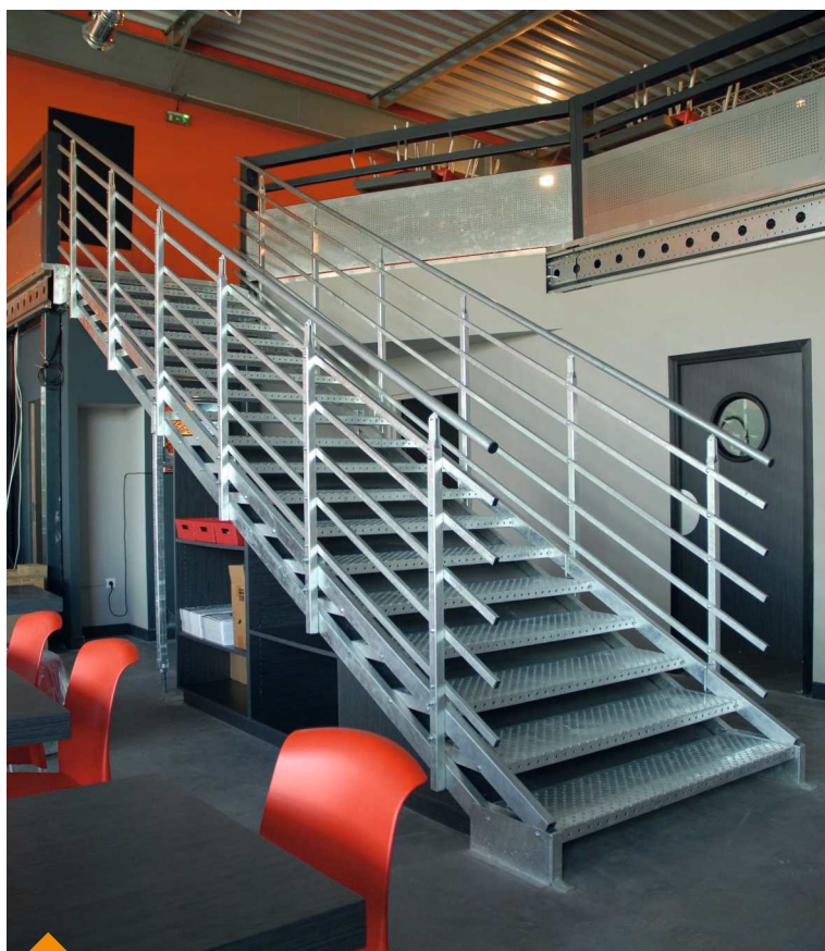
Réalisation équipée d'une mezzanine et de cloisons de bureaux.
