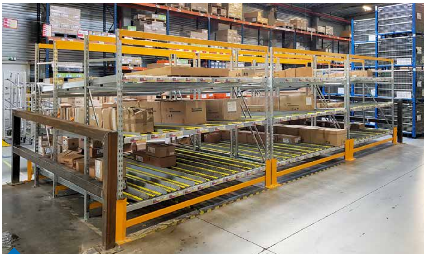
Prorack+ équipé de cadres dynamiques. Vue du côté du chargement à l'arrière du meuble. Les colis descendent de manière gravitaire jusqu'à la zone de prélèvement à l'avant.
