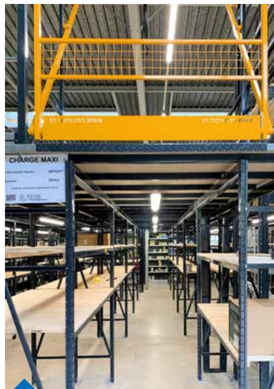
Le plancher de la plateforme repose sur les rayonnages Prorack+.
