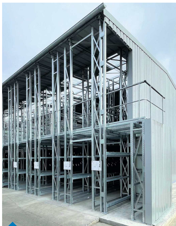
Bâtiment autoportant, plateforme avec allées de circulation sur base de rayonnage Propal 3.
