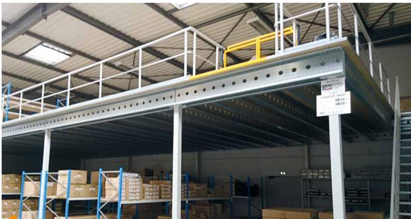
Plateforme équipée d'un portillon avec sas de dépose.
